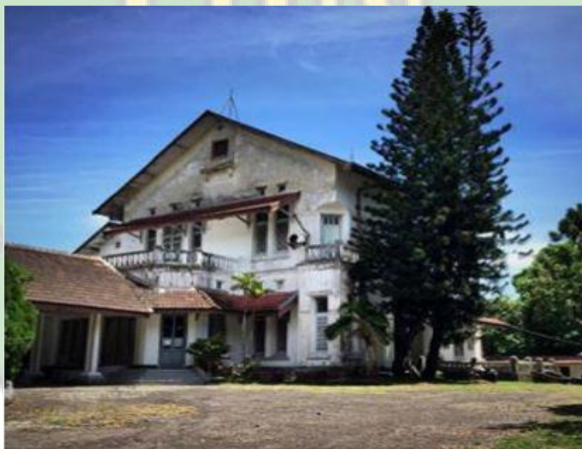
Gambar 1: Hotel Samudera yang terletak di Jalan Diponegoro
