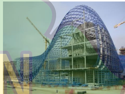
Penggabungan rangka ruang dengan material kaca
