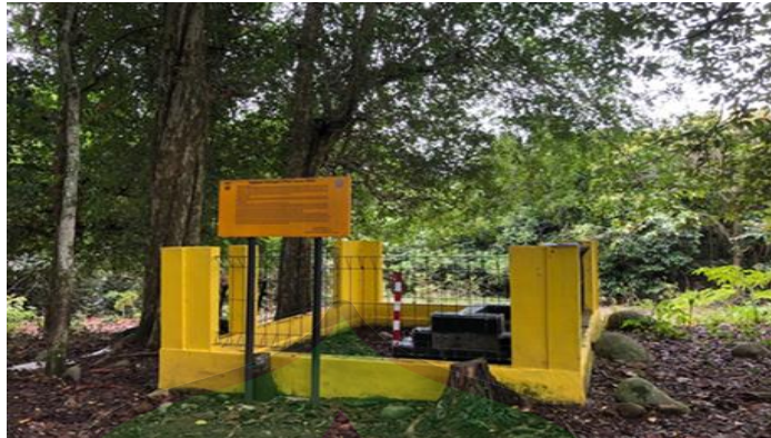
Gambar 3. Kondisi sekitaran Makam Teungku Chik Pante Kulu yang sudah di renovasi. (Dok. Penulis)
