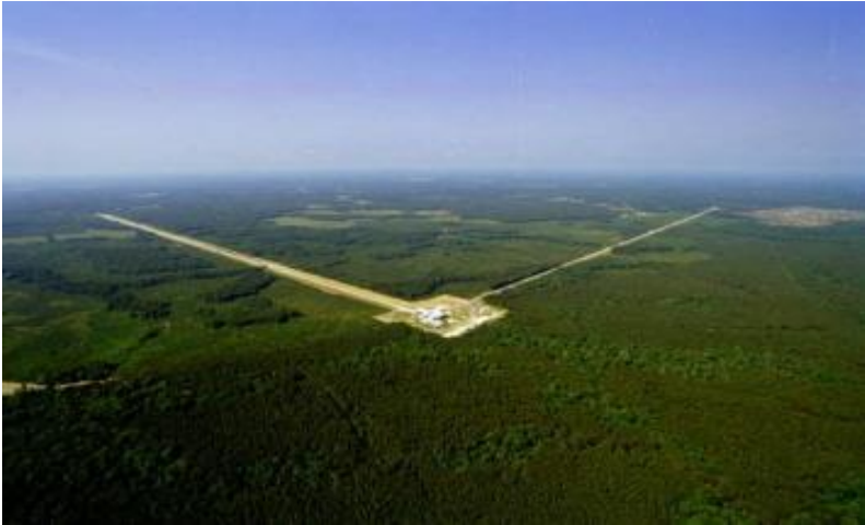
Gambar 4.9 LIGO Livingston. Lengan yang Anda lihat sebenarnya adalah struktur beton yang melindungi tabung vakum, yang berada tepat di dalamnya. 'Selungkup' beton melindungi tabung vakum yang sangat penting dari kemungkinan kerusakan lingkungan. (sumber : Caltech / MIT / LIGO Lab)
