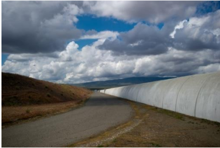
Gambar 4.11 Salah satu 'lengan' LIGO Hanford (tabung vakum berada di dalam penutup beton). " Mid-station " (setengah jalan ke ujung lengan) hampir tidak terlihat sejauh 2 km. (sumber: Kim Fetrow / Imageworks)
