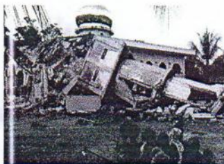
Gambar.3. Akibat Gempa Bumi
