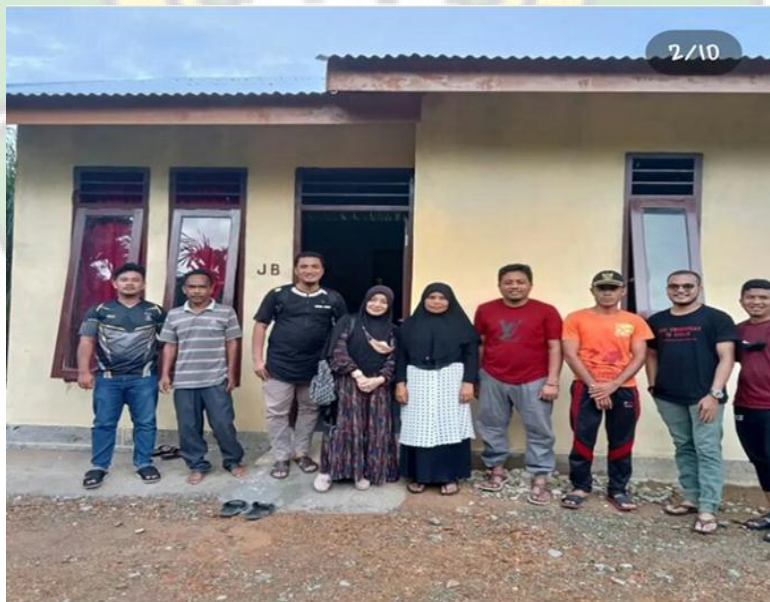
Gambar 4. Contoh Pembangunan Rumah (Sesudah)
