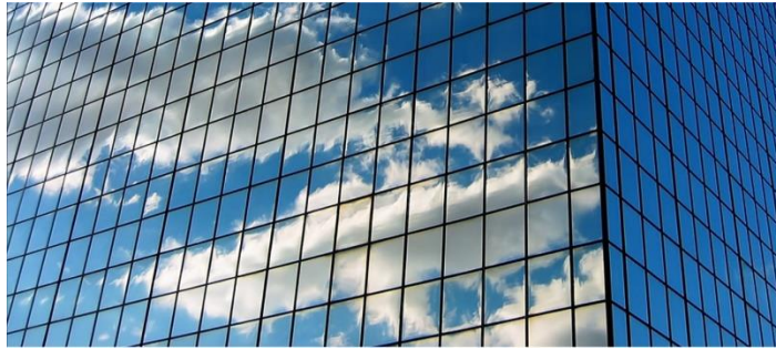
Gambar 4.8 Pemasangan Kaca Film Pada Bangunan
