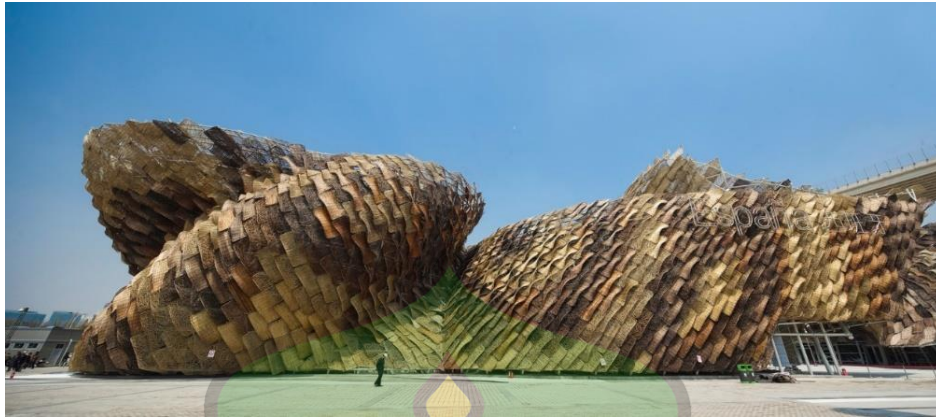
Gambar 3.4 Paviliun Spanyol Sumber : https://bit.ly/3eO2UmB
