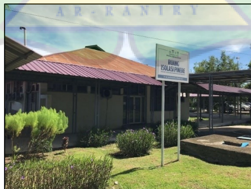
Gambar 2 28 Ruang Isolasi Pinere di RSUD dr. Zainoel Abidin Sumber : Dokumentasi Pribadi
