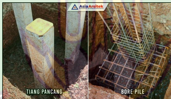
Gambar 4 40 Pondasi Tiang pancang dan Borepile
