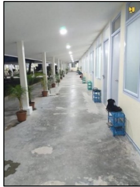
Gambar 2 24 Koridor Bangunan Observasi/ Penampungan/ Isolasi Penyakit Menular di Pulau Galang (Ruang Observasi Zona B)
