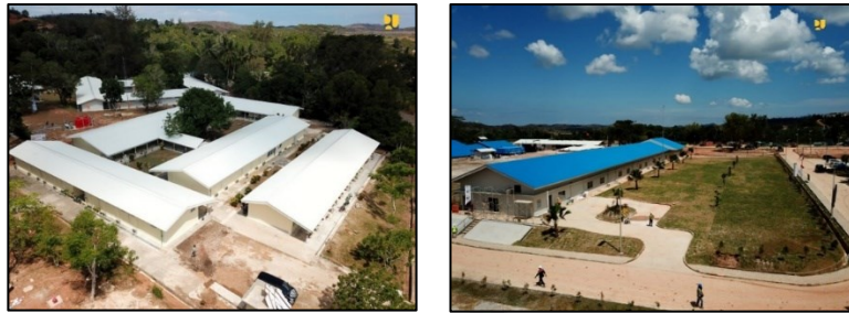
Gambar 2 22 Bangunan Observasi/ Penampungan/ Isolasi Penyakit Menular di Pulau Galang Sumber : https://eppid.pu.go.id/page/kilas_berita/1710/Fasilitas-Observasi-Penampungan-Isolasi-untuk-Pengendalian-Infeksi-Penyakit-Menular-di-Pulau-Galang-Siap-Digunakan
