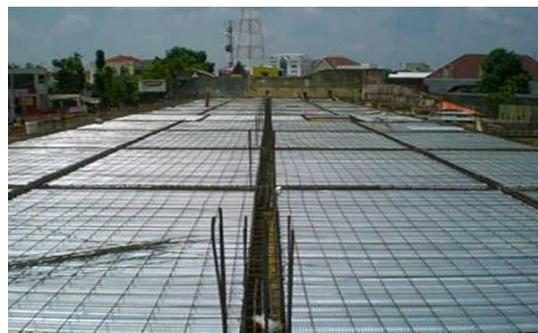
Gambar 5.21 Struktur Atap Dak
