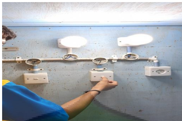
Gambar 4.3 Hasil Rangkaian Miniatur Instalasi Penerangan Rumah
