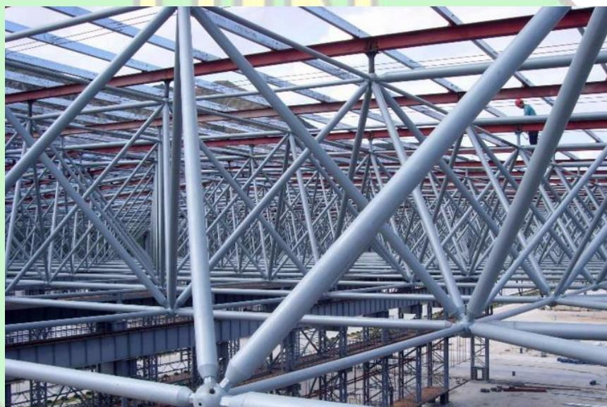
Gambar 5. 42 Struktur Rangka Ruang
