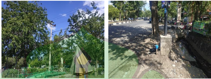
Gambar 4.4 eksisting utilitas Sumber: dokumentasi pribadi
