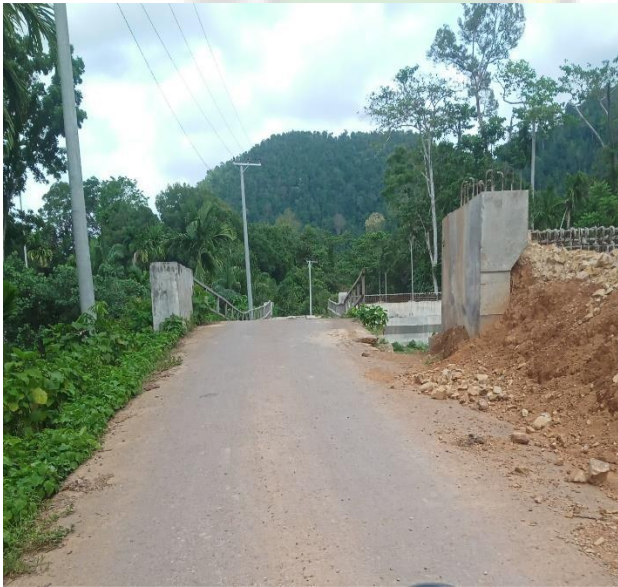
Ket: Jembatan Gampong Pante Kuyun
