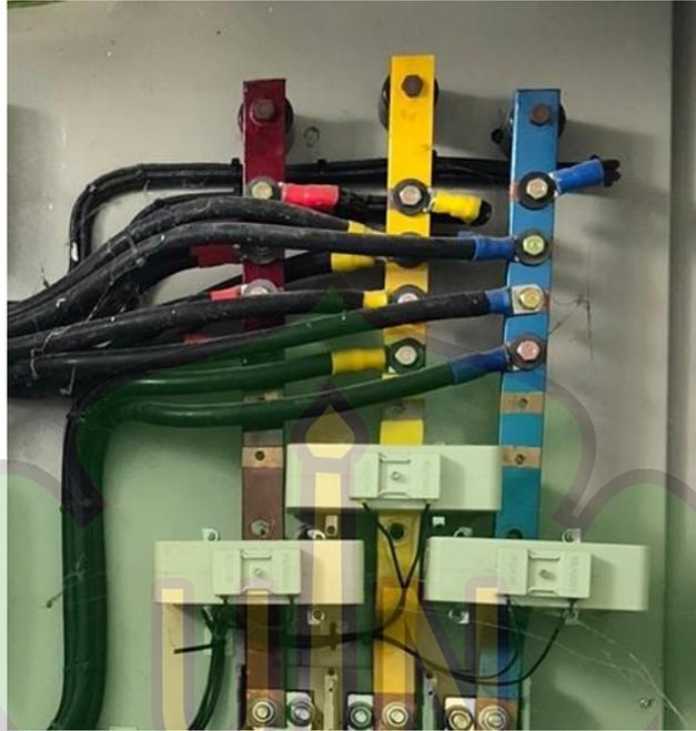
Gambar 4.4 Busbar pada panel
