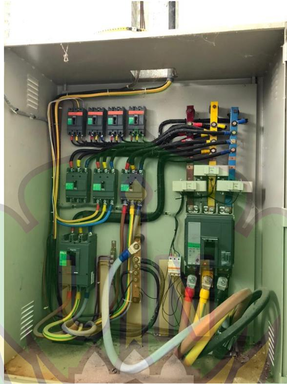
Gambar 4.3 warna kabel
