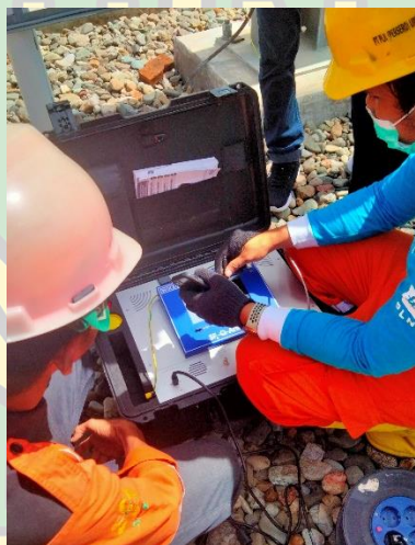
Melihat Hasil Pengukuran menggunakan Alat Ukur Insulation tester
