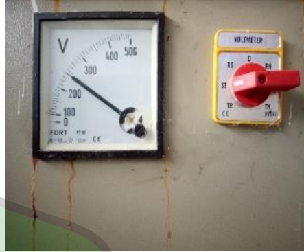
b) Tegangan fasa S-T pada panel MDP
