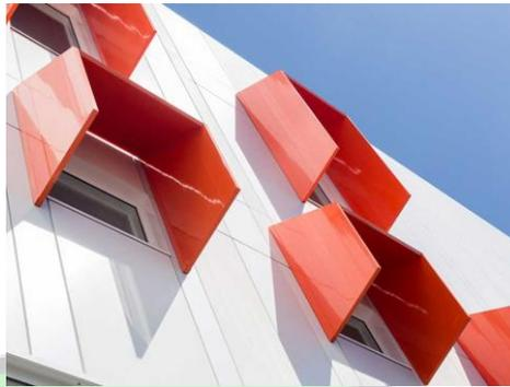
**Gambar 4.16** Contoh Penerapan *Sun Shading*
