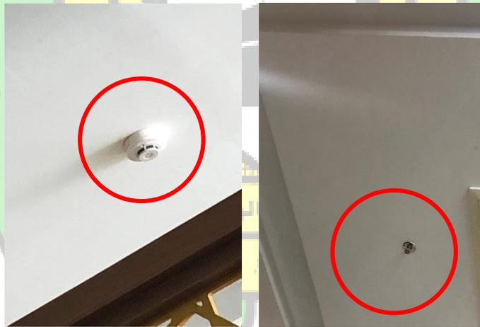
**Gambar 2.17** *sprinkler/smoke detector* Dalam Gedung DPRK Banda Aceh
