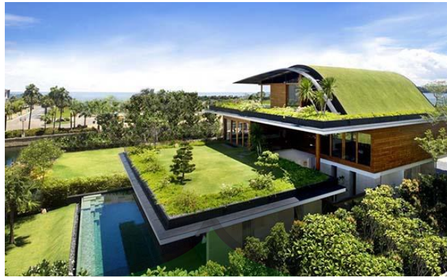
Gambar 5 20 Vegetasi Rooftop Sumber: Hasil Konsep
