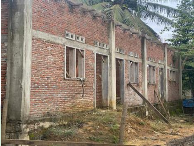
Kamar bilik yang sedang dibangun
