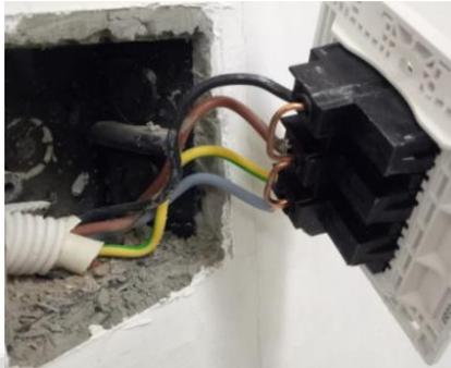
Gambar 4.6 Sambungan antar konduktor
