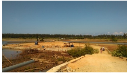
Gambar 4.23 Kondisi Jalan Pada Site Sumber: Dokumentasi Pribadi,2020
