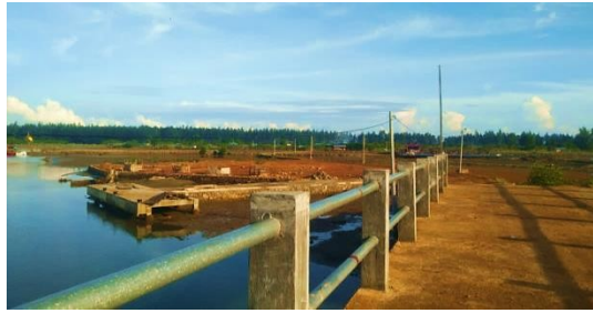
Gambar 4.4 Jaringan Listrik Sumber: Dokumentasi Pribadi, 202
