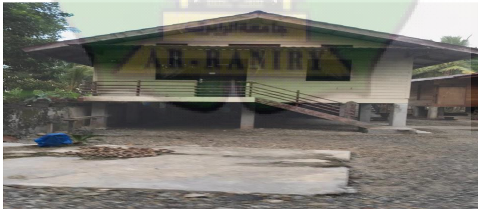
Gambar 4. 11 Rumah warga dengan pondasi lebih tinggi di kawasan rawan banjir
