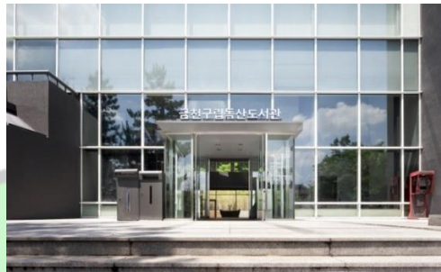
Gambar 2.36. Gambar konsep bentuk renovasion cultural geumcheon (Smber: arch daily 2021)
