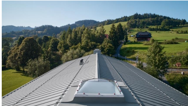
Gambar 2. 20 Atap Bangunan Nový Hrozenkov Sumber : Archdaily.com
