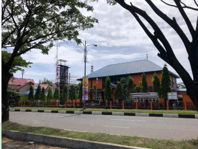
Gambar 4. 11 Kantor BASARNAS Aceh Sumber : Dokumentasi Pribadi, 2022
