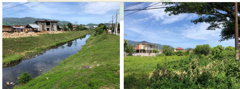
Gambar 4. 10 Kondisi Jaringan Utilitas Pada Tapak Sumber : Dokumentasi Pribadi, 2022
