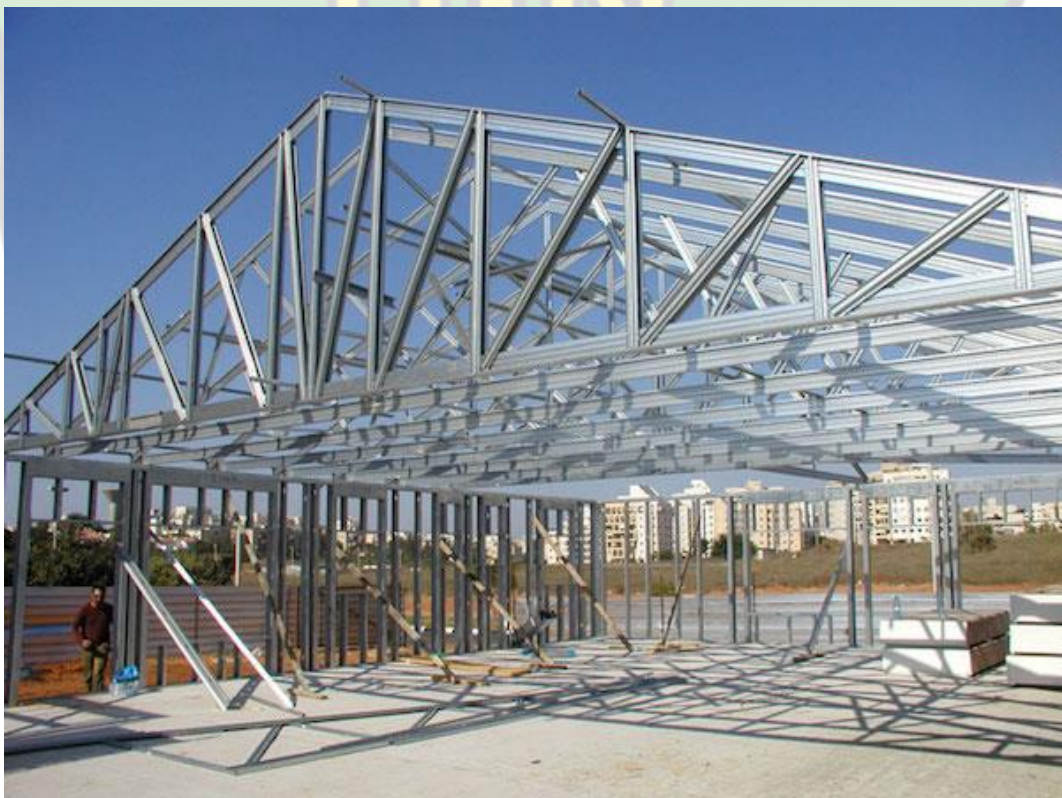
Gambar 5. 16 Struktur Atap Sumber : Pinhome.id
