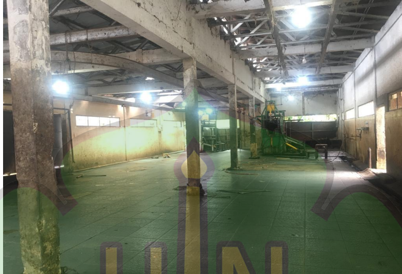
Gambar 3. 3 Ruang Pemotongan Hewan
