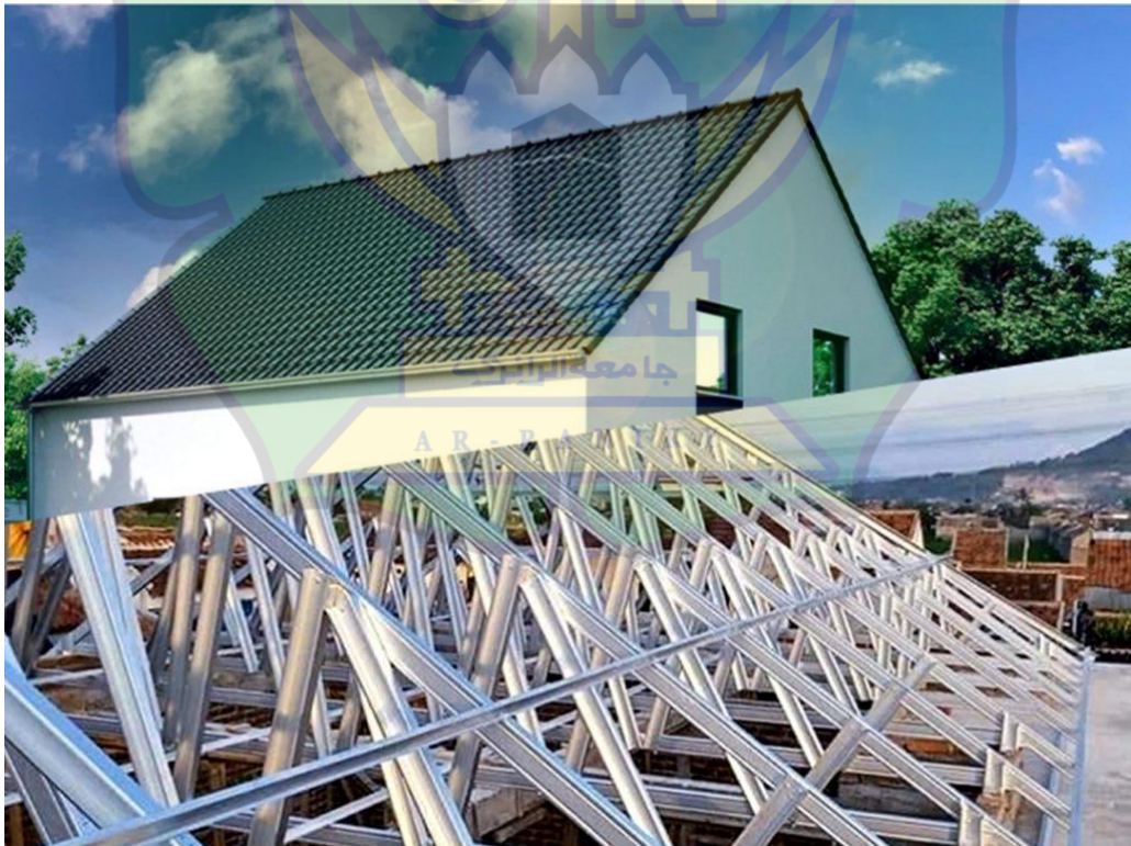
Gambar 4. 21 atap pelana dengan baja ringan (Sumber : https://kepuhkencanaarum.com )
