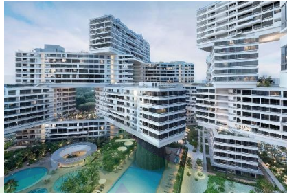
Gambar 3. 5 Bangunan The Interlace
