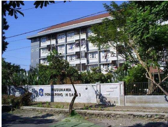
Gambar 2. 25 Gedung Rusunawa Penjaringan Sari 3
