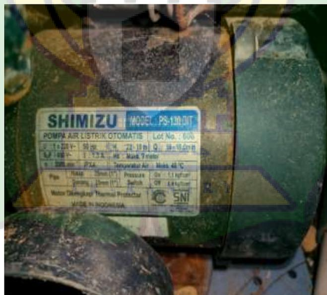
Gambar 4.10. Namemplate mesin pompa
