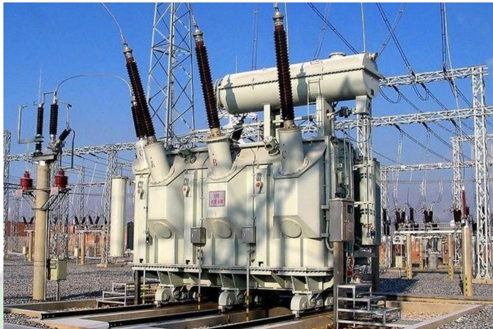
Gambar 2. 2 Gambar trafomator tenaga listrik
