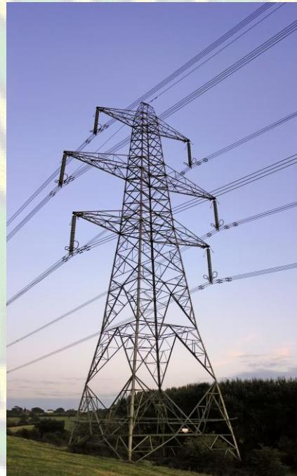
Gambar 2.5 Gambar saluran listrik udara tegangan tinggi
