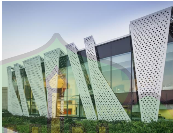
Gambar 4. 15 Penggunaan Sun Shadding/ SecondarySkin (Sumber: www.pining.com )
