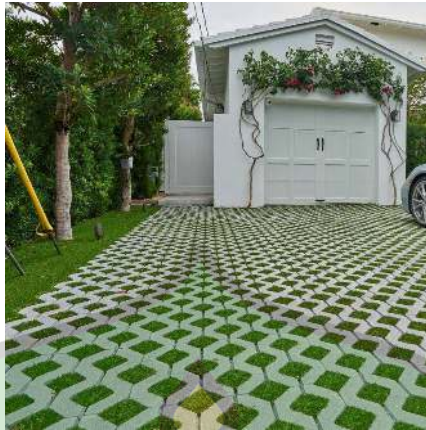
gambar 4. 18 grass block sebagai resapan tambahan sumber: paveroutlet.com
