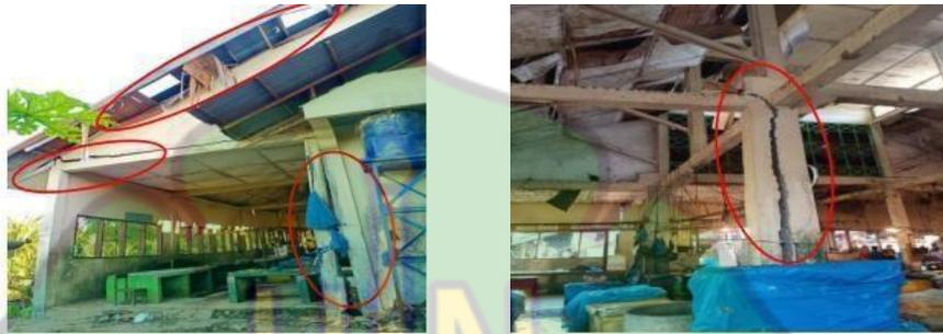
**Gambar4. 2 Retakan dinding dan kerusakan pada kolom atap ( Sumber : Analisa Pribadi)**
