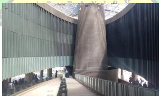
Gambar 3.10 Jembatan Museum Tsunami Aceh Sumber: Dokumentasi Pribadi, 2022
