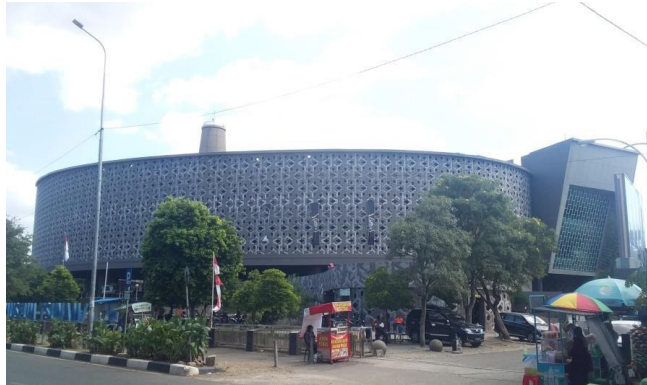
Gambar 3.5 Museum Tsunami Aceh Sumber: Dokumentasi Pribadi, 2022
