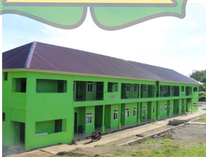
Gambar 2.194 Gedung Asrama Darul Quran Aceh
