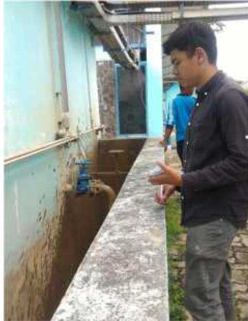
Gambar 4.5 Proses Pembuangan Lumpur Secara Berkala
