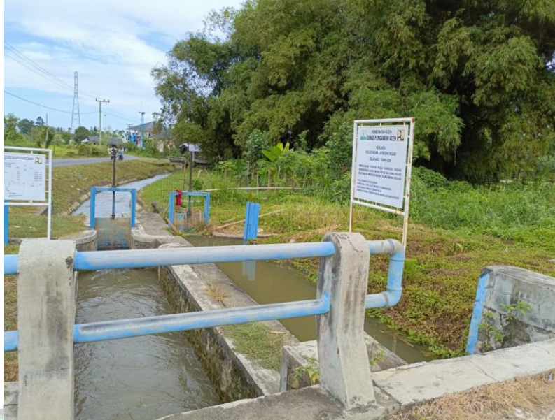
Gambar 4.7 Irigasi Lueng Beureueh yang sudah di renovasi (dampak samping kiri) Sumber: Dokumentasi pribadi 25 April 2025
