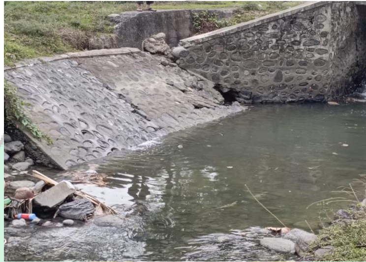
Gambar 4.2 Salah satu bekas irigasi yang ada di Lueng Bintang yang sudah di renovasi Sumber: Dokumentasi pribadi 10 Agustus 2025
