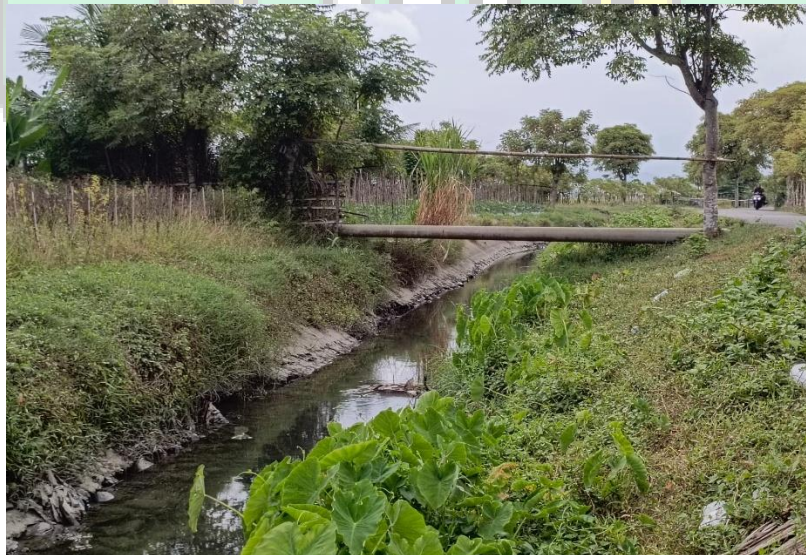
Gambar 4.3 Salah satu irigasi yang sudah di bongkar di Sungai Bintang Sumber: Dokumentasi pribadi 10 Agustus 2025
