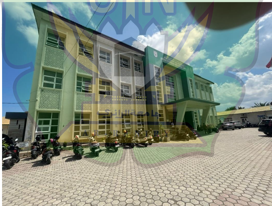
Dokumentasi Gedung Dinas Pendidikan dan Kebudayaan Kota Banda Aceh
