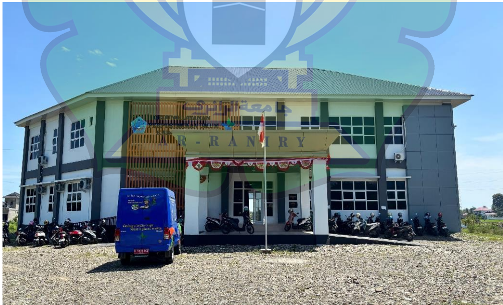
Gambar 4. 1 Gedung Dinas Perpustakaan dan Kearsipan Kabupaten Pidie Jaya
