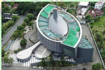
Gambar 3.7. Bagian Atap Museum Tsunami Aceh
