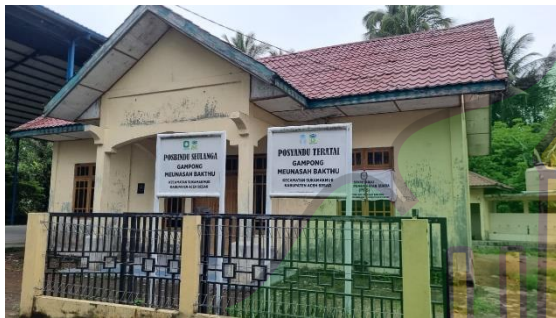
Gedung PKK Gampong Meunasah Bakthu
