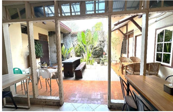
Gambar 4.3 Bukaian Eksisting pada Area Belakang Untuk Mendukung Pencahayaan dan Ventilasi Alami (Sumber: Dokumentasi Penulis, 2026)
