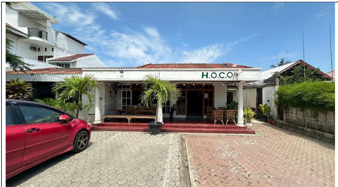
Gambar 8.1 Tampak Depan Bangunan
