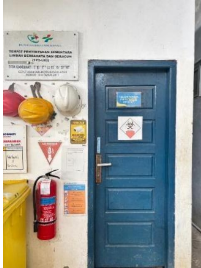
Gambar 4. 6 Tampak Depan TPS Sumber: Dokumentasi Pribadi, 2026
