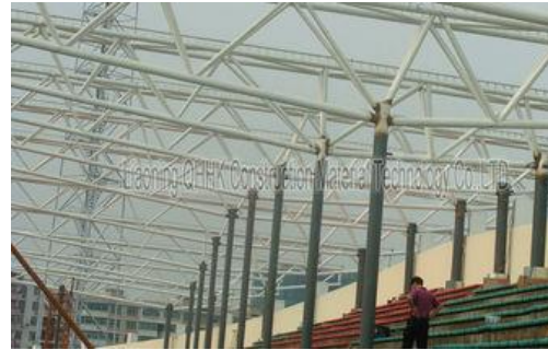
Gambar 4. 36 Struktur rangka baja Sumber: indonesian.prefabricatedsteelstructures.com
