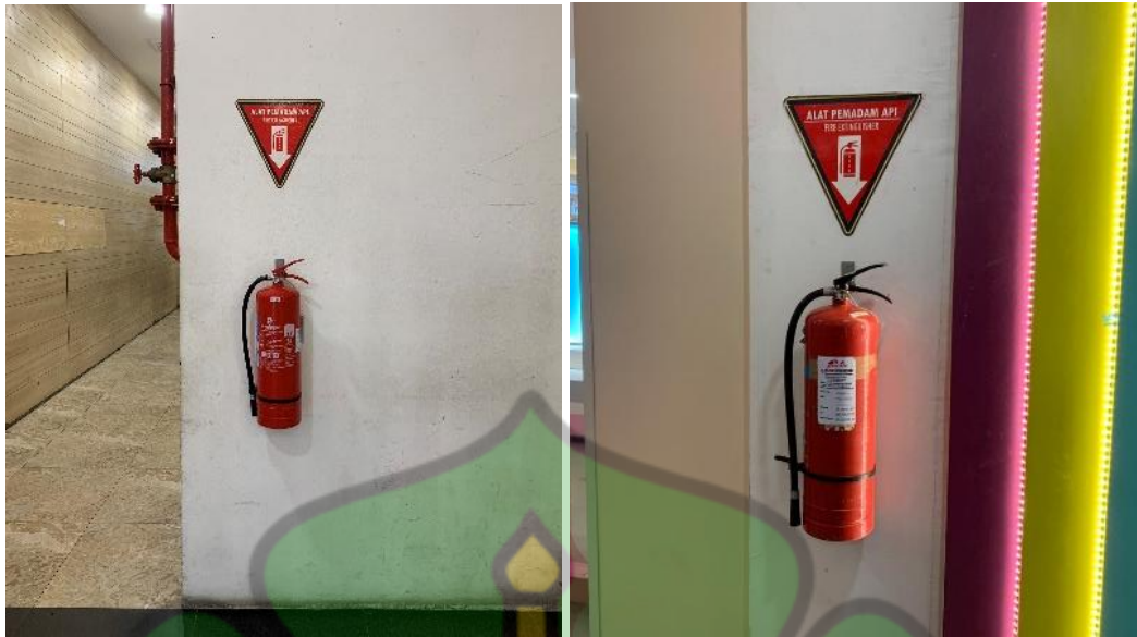
Gambar 4. 1 Peletakan APAR yang sesuai Sumber : Hasil Observasi, 2025
