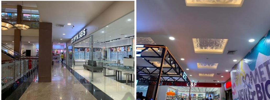
Gambar 4. 24 Plafon area koridor existing tanpa sprinkler Sumber : Hasil Observasi, 2026
