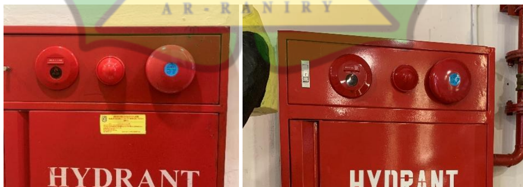
Gambar 4. 8 Alarm kebakaran Sumber : Hasil Observasi, 2026
