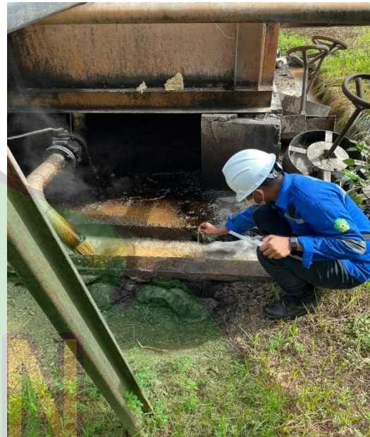
Pengecekan Suhu di Outlet Fat Pit
