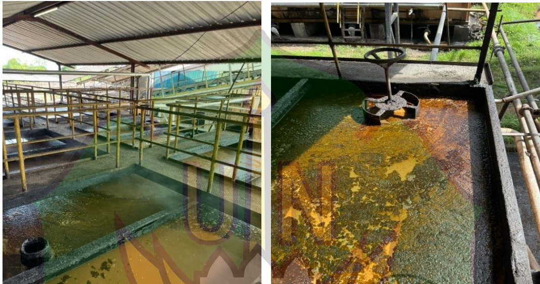
Gambar 2.2 Bak Pemisah Minyak dan lemak ( Fat pit )
