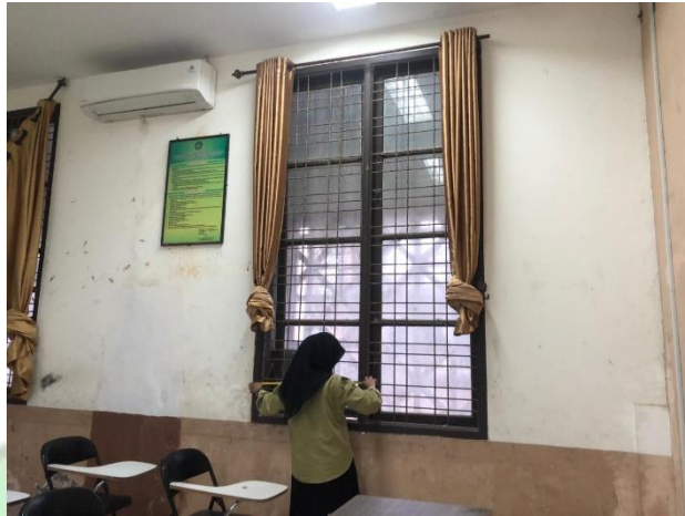
Pengukuran jendela pada ruang
