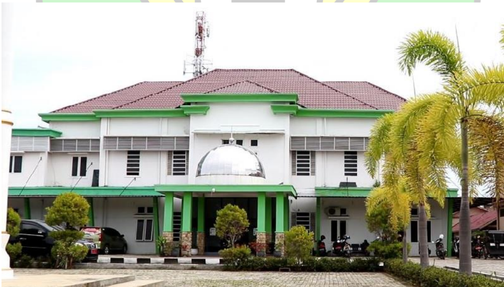
Gambar 3.1 Kantor Baitul Mal Aceh
