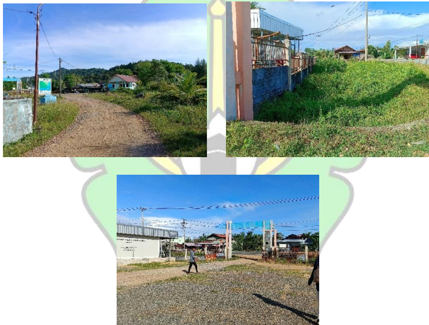
Gambar 4. 3 Aksesibilitas Jalan dan drainase
