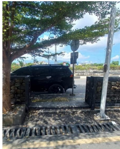
Gambar 4. 14 Tangga Jalur Pedestrian (Sumber: Dokumentasi Pribadi, 2026)
