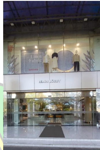
Gambar 4. 16 Tangga Pintu Utama (Sumber: Dokumentasi Pribadi, 2026)
