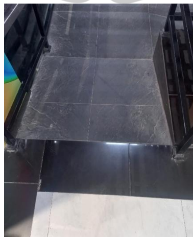
Gambar 4. 27 Ramp Dalam Bangunan (Sumber: Dokumentasi Pribadi, 2026)
