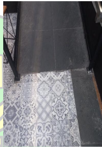
Gambar 4. 26 Ramp Dalam Bangunan (Sumber: Dokumentasi Pribadi, 2026)
