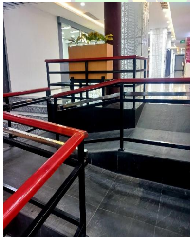
Gambar 1.3 Ramp Plaza Aceh (Sumber: Dokumentasi Pribadi, 2025)
