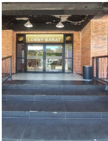
Gambar 4. 20 Tangga Lobi Barat (Sumber: Dokumentasi Pribadi, 2026)
